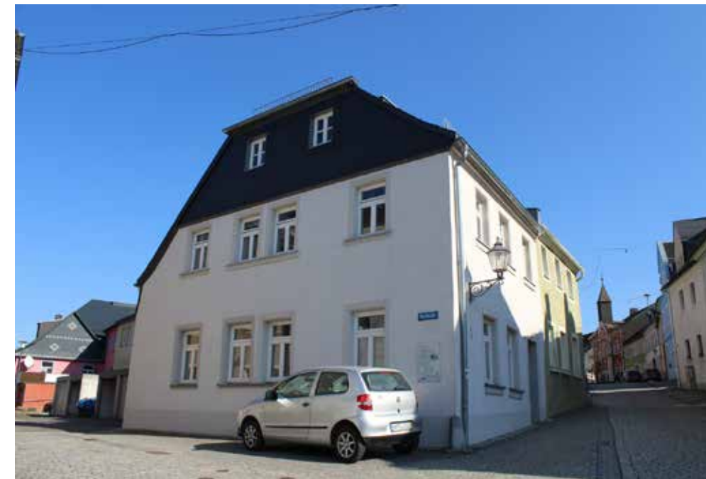
Marktplatz 1, Zweigeschossiger Sattel-dachbau, verschiefelter Straßengiebel mit Krüppelwalm, Scheitelstein über Haustür, bez. 1844; Kulturdenkmal lt. Liste. Das Gebäude markiert heute den westlichen Stadteingang. © transform
