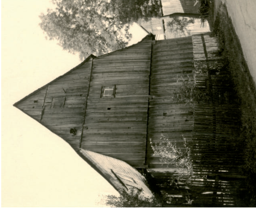
Nicht mehr existenter Scheunenbau, ehem. hinter der alten Dreschhalle befindlich (im Bereich der heutigen Poststraße). Der Bau ist in für Lichtenberg typischer Schrottbauweise errichtet und besitzt eine verbretterte Fassade und ein Mansarddach. © Archiv Welte
