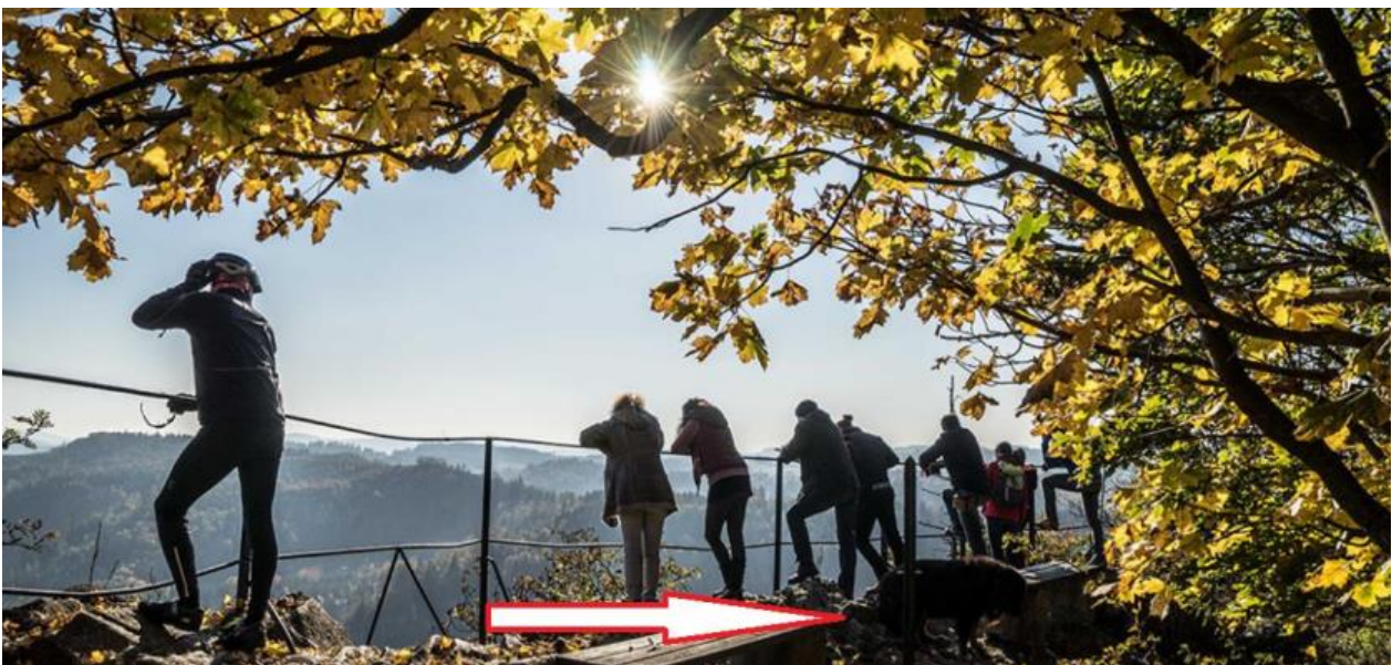
Abbildung 17: Zurücksetzen der Absturzsicherung am König David
