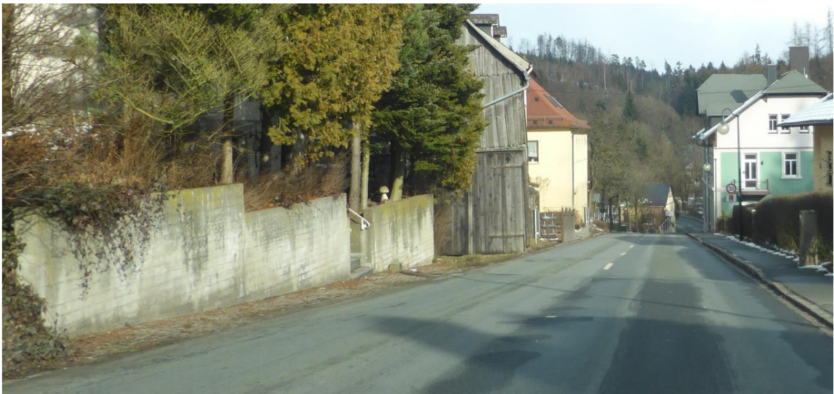
Abbildung 14: St 2198 (Humboldtstraße) im Ortsbereich Hölle, Blick nach Ost. Fehlender Gehweg auf der linken Straßenseite.
