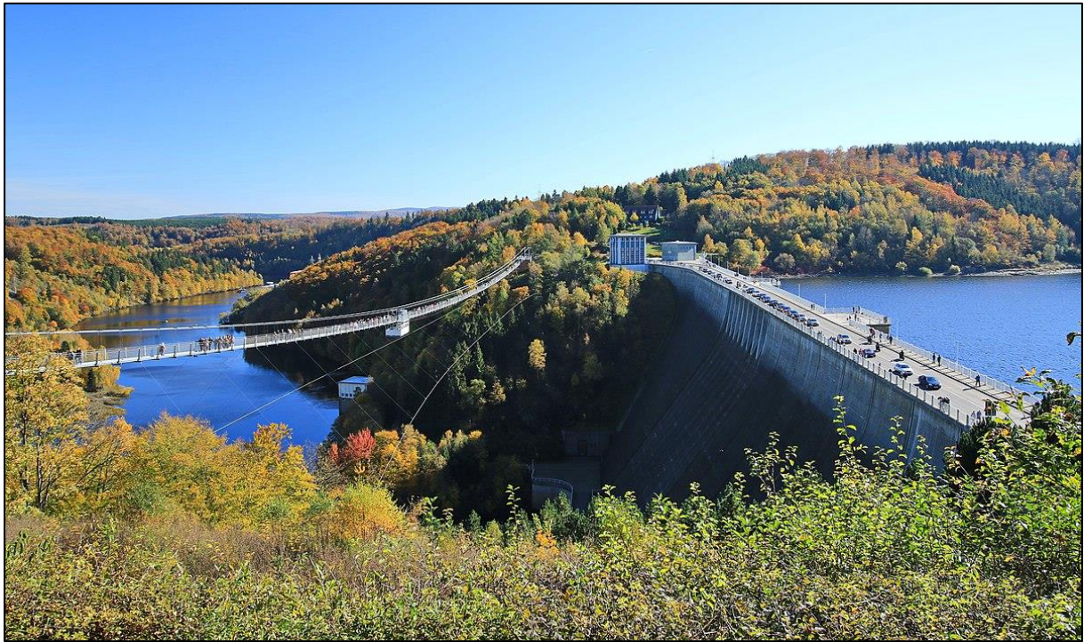
Abbildung 15: Hängeseilbrücke Titan-RT, Rappbodetalsperre
