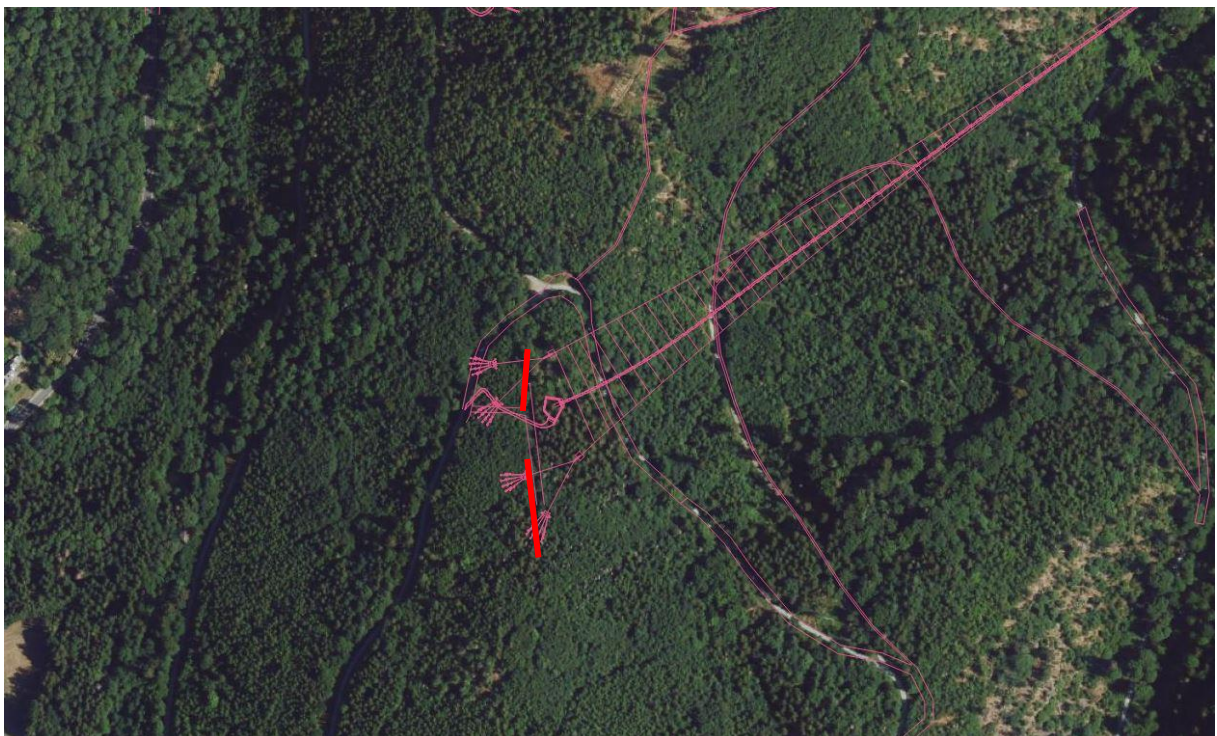
Abbildung 7: Auswertungsbereich Höhendaten Höllentalbrücke West-Masten Kamm.
