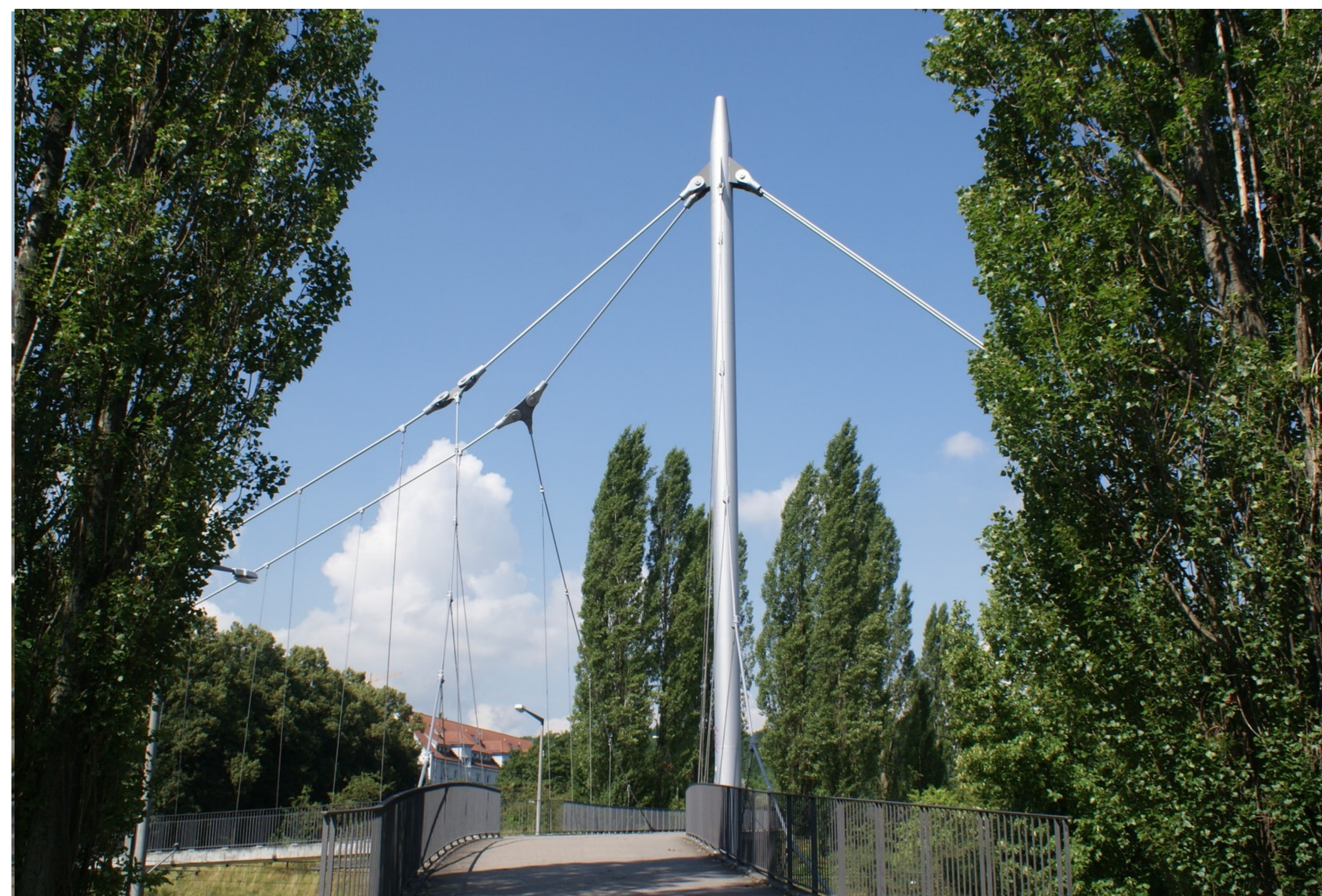
Mast der IGA-Brücken über die Heilbronner Straße in Stuttgart in weißaluminium (RAL 9006).
