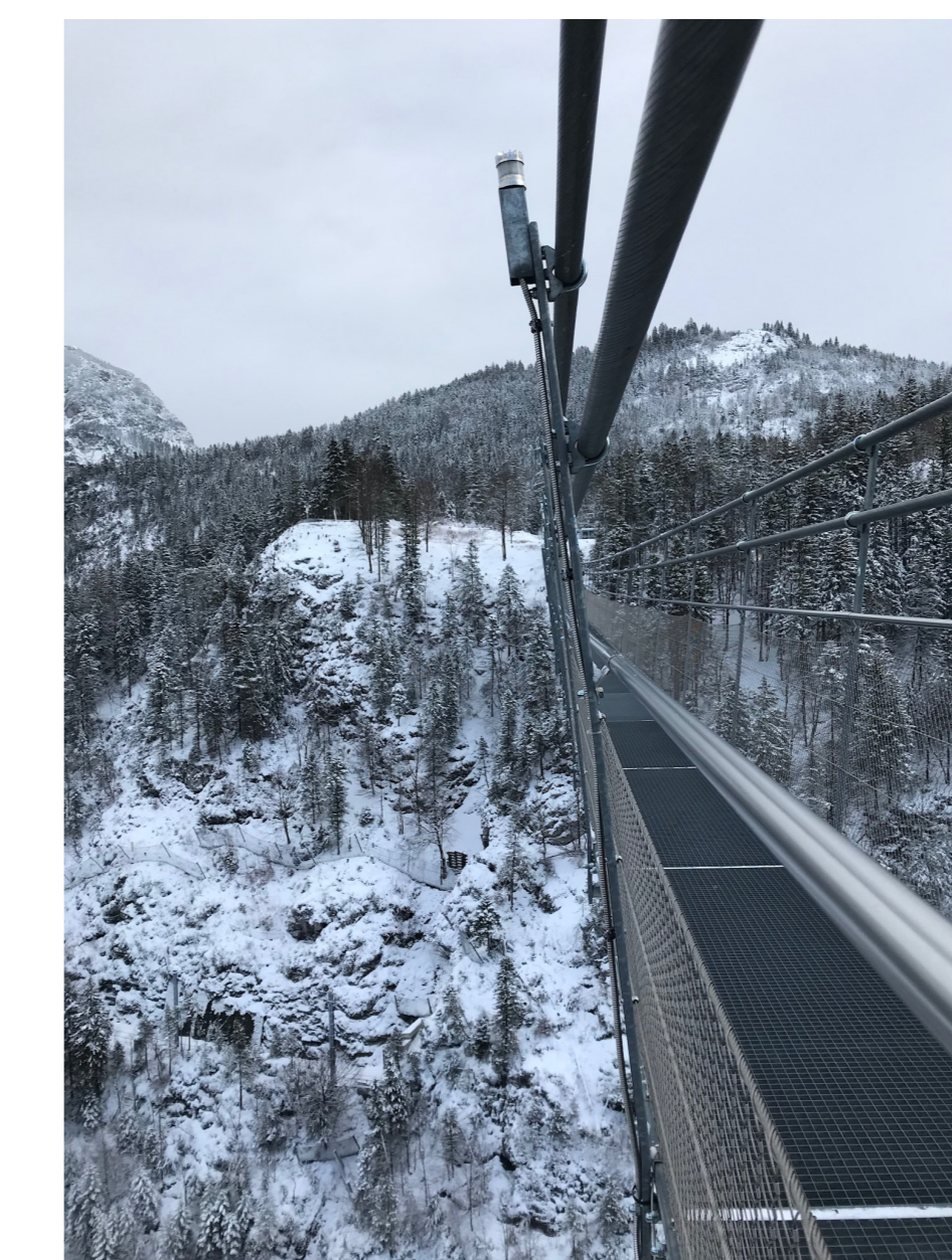
Flugsicherungsleuchte für die Nachtzeichnung am Beispiel der Fußgängerbrücke Highline Reutte Tirol
