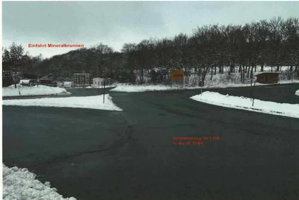
Einmündung St 2198 in die St 2195
