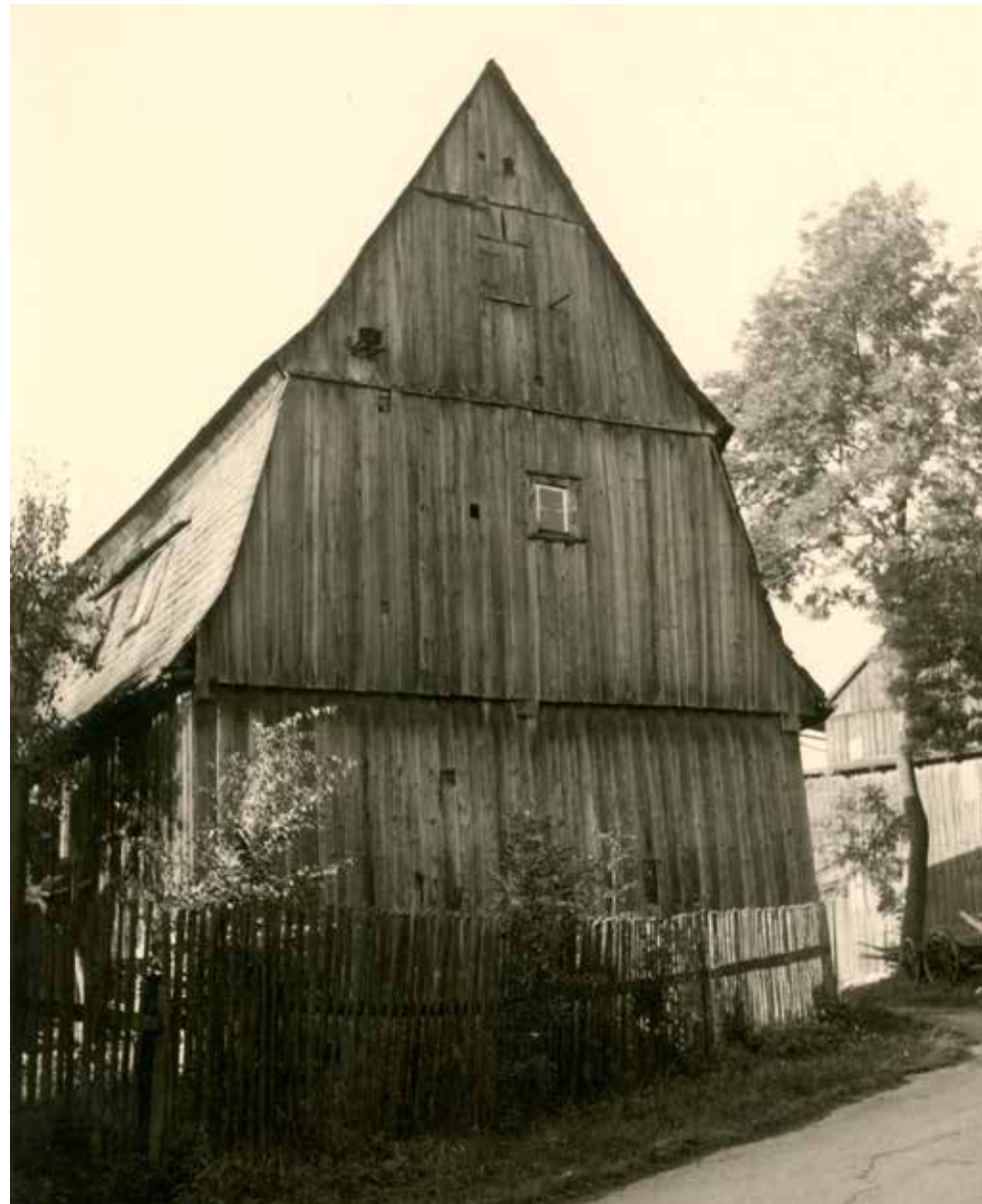
Nicht mehr existenter Scheunenbau, ehem. hinter der alten Dreschhalle befindlich (im Bereich der heutigen Poststraße). Der Bau ist in für Lichtenberg typischer Schrothbauweise errichtet und besitzt eine verbretterte Fassade und ein Mansarddach. © Archiv Welte
