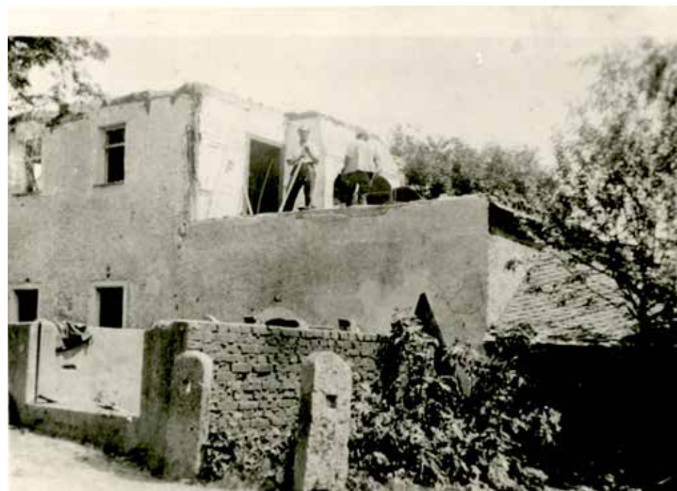
Abbruch des alten Hospitals an der Nailaer Straße während des Abbruchs 1930.
