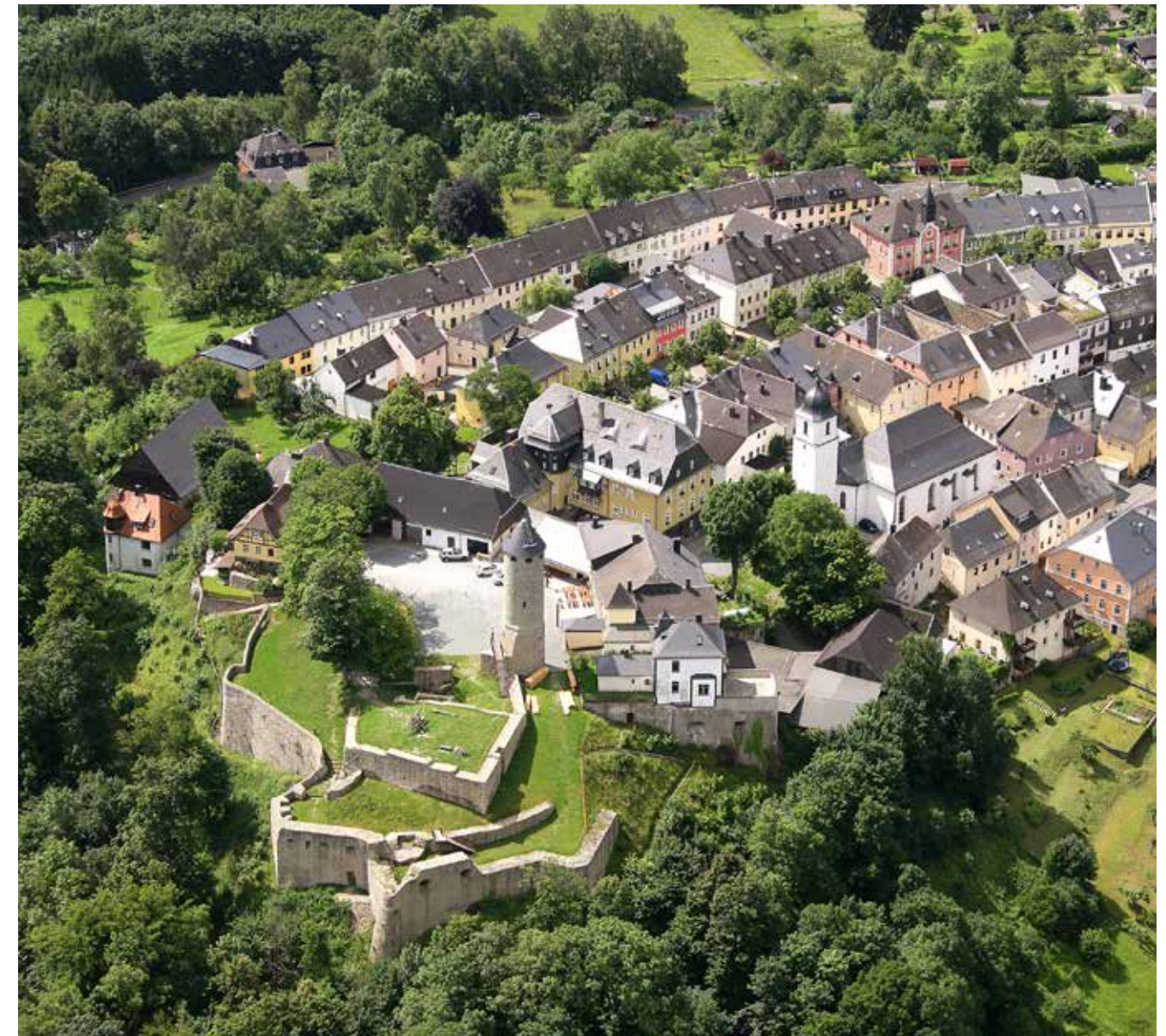
Luftaufnahme Lichtenberg von Osten mit Blick über die Burgruine der alten Lichtenburg. Heute dominiert der schwarze Schiefer, bzw. teilweise auch dunkler Schieferersatz die Dachlandschaft von Lichtenberg © Archiv Welte
