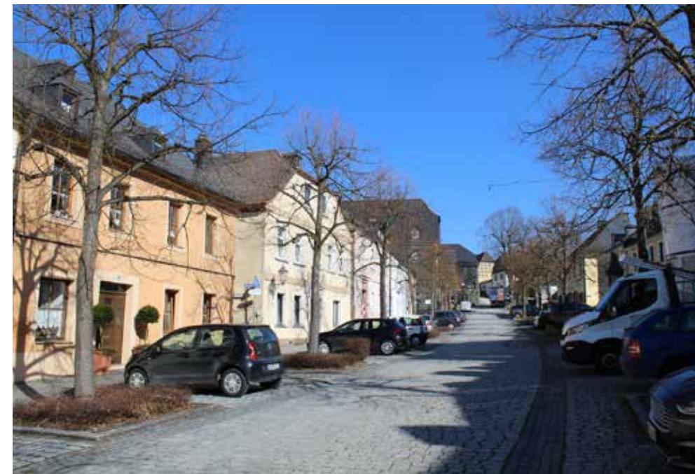
Marktplatz mit Blick Richtung Waldenfelsplatz. Das Marktplatzensemble zeigt bis auf das alte Forsthaus (Marktplatz 28) heute eine weitgehend geschlossene Reihe von Traufseithäusern, die Mehrzahl davon erhaltenswert. Das Fassadenbild geht dabei zurück auf die beiden Stadtbrände 1814 und 1869; die Gebäude sind im Kern jedoch teilweise älter, vgl. u.a. Marktplatz 31 (Bildmitte links).
