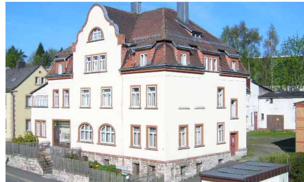
Das 1910 erbaute Schlachthaus an der Bad Stebener Straße kurz vor dem Abbruch im Jahr 2008 © Stadtarchiv (Schade)
