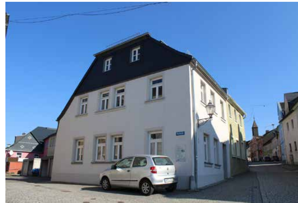
Marktplatz 1, Zweigeschossiger Satteldachbau, verschiefertes Straßengiebel mit Krüppelwalm, Scheitelstein über Haustür, bez. 1844; Kulturdenkmal lt. Liste. Das Gebäude markiert heute den westlichen Stadteingang. © transform
