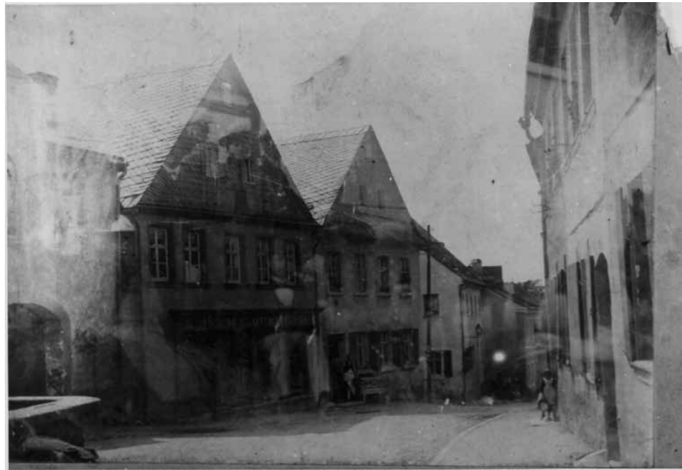
Unterer Marktplatz Blick Richtung ehem. Vorderes Tor, historische Aufnahme vor einem Brand in diesem Bereich aus dem Jahr 1894 - Marktplatz 8 mit schieferverkleidetem Fachwerkgiebel und giebelständig zum Straßenraum ausgerichtet. © Archiv Welte
